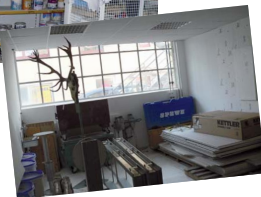
Werkstatt und Lager vor dem Umbau
